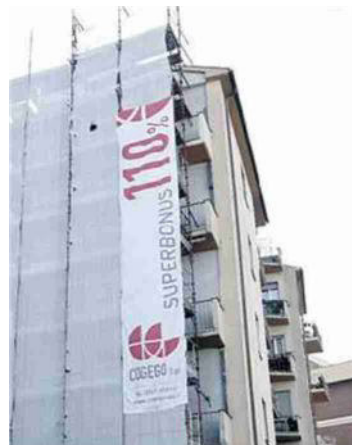
Uno dei cantieri finanziati dal “vecchio” Superbonus al 110%
