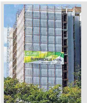
Un cantiere del superbonus
