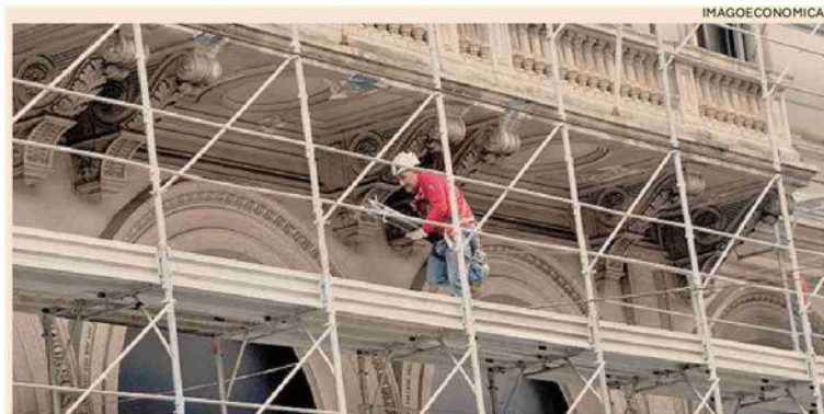
Il pacchetto. Le misure per aumentare la sicurezza nei cantieri
