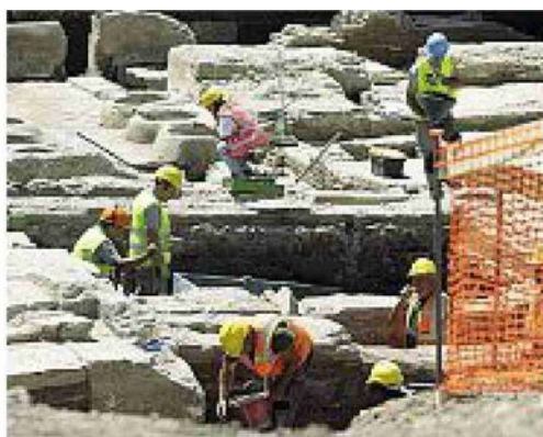
Il cantiere per il sottopasso di piazza Pia a Roma
